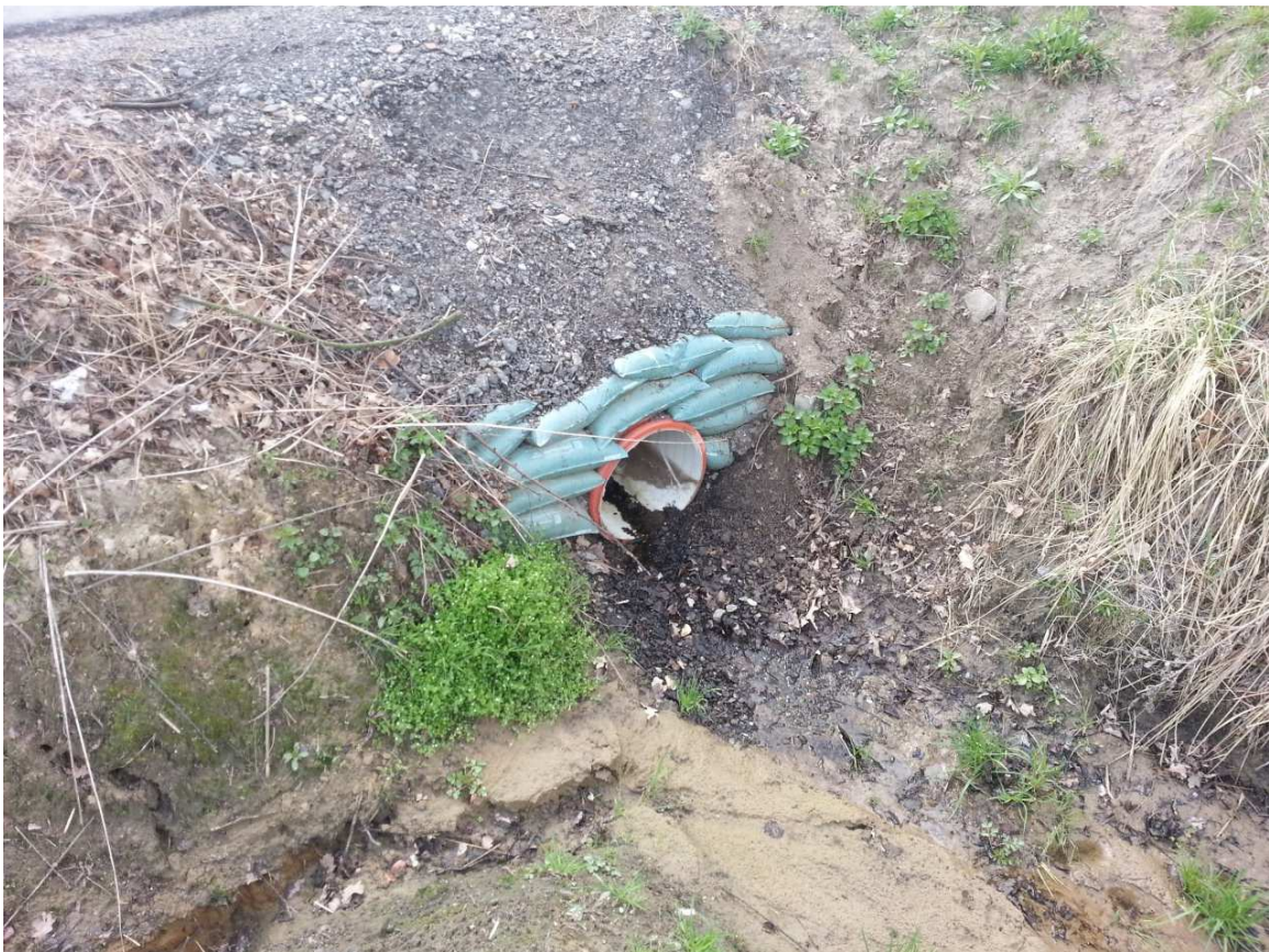
fot. 2 Widok na przepust w km 0+400.58, od strony wylotu.
