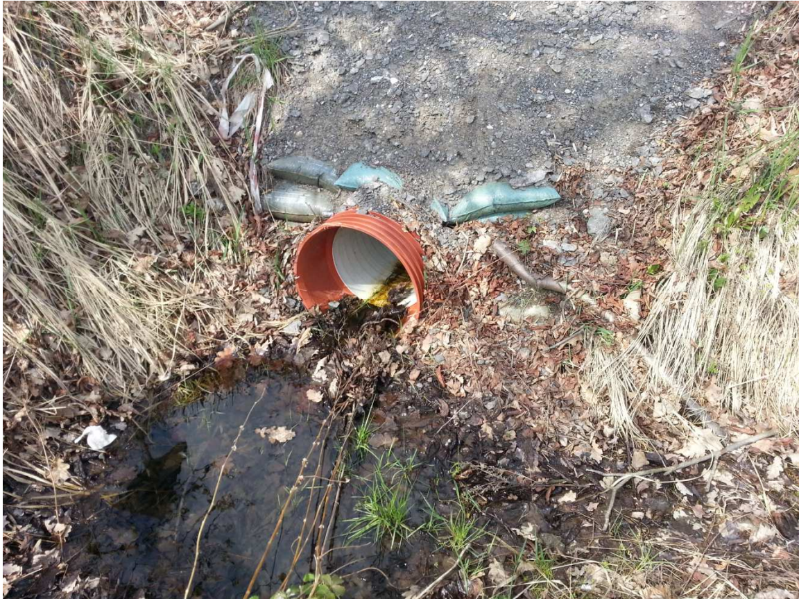
fot. 1 Widok na przepust w km 0+400.58, od strony wlotu.
